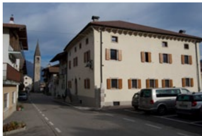
L'ex canonica ristrutturata (foto F. Brunelli)
